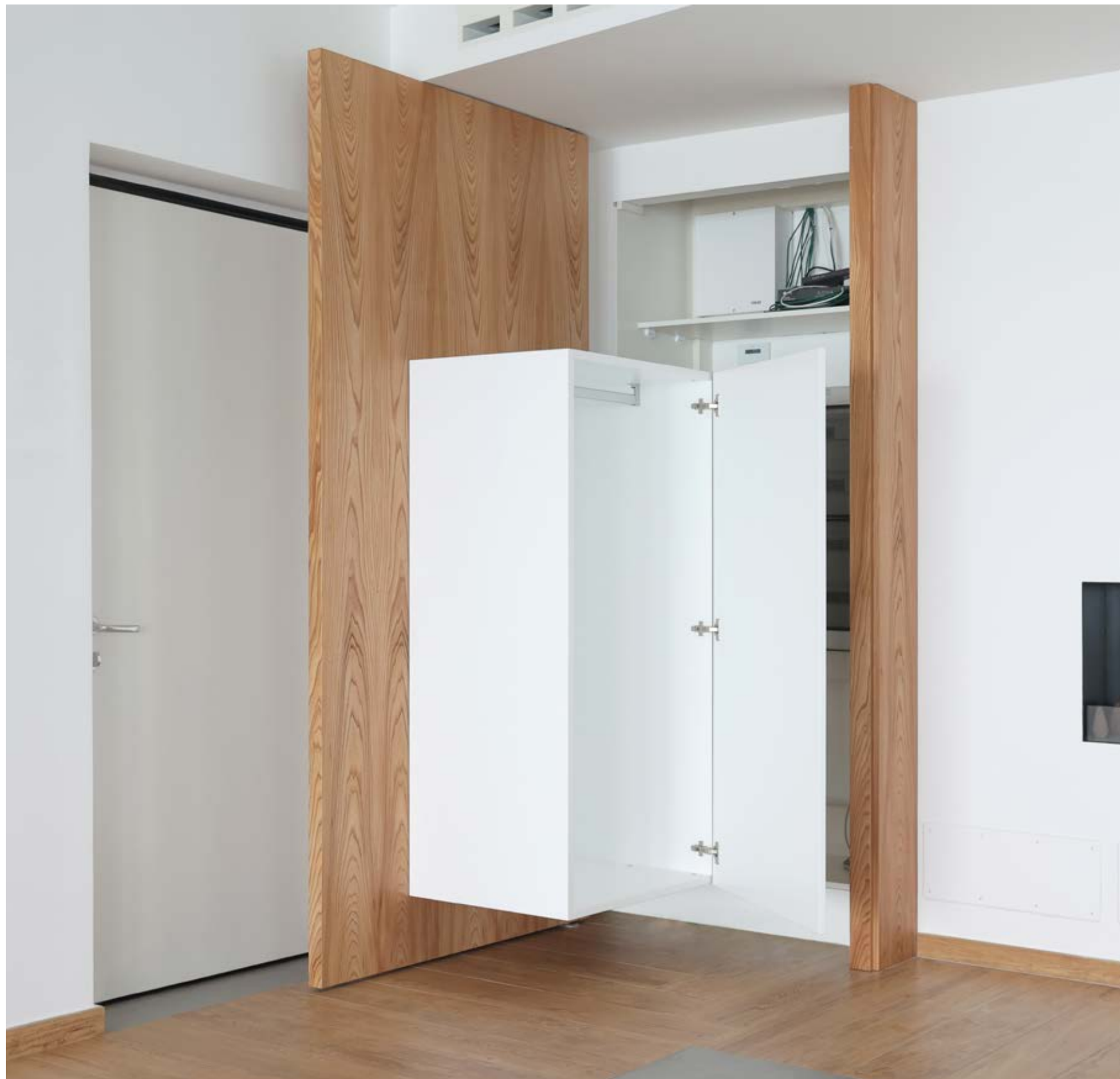
porta a bilico a copertura vano tecnico con modulo guardaroba retrostante
